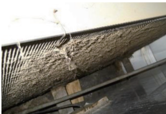
コンデンサーが目詰まりすると、冷却に時間がかかり、細菌数の増加や電気代アップにつながります。
