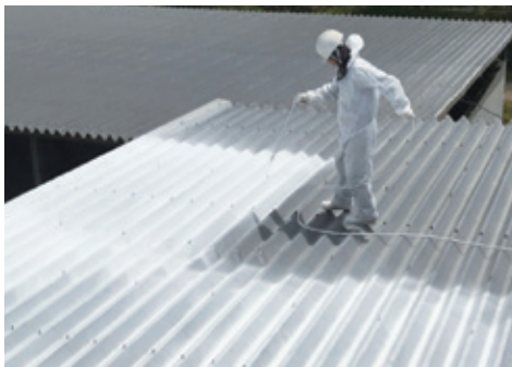
【塗布作業状況】
